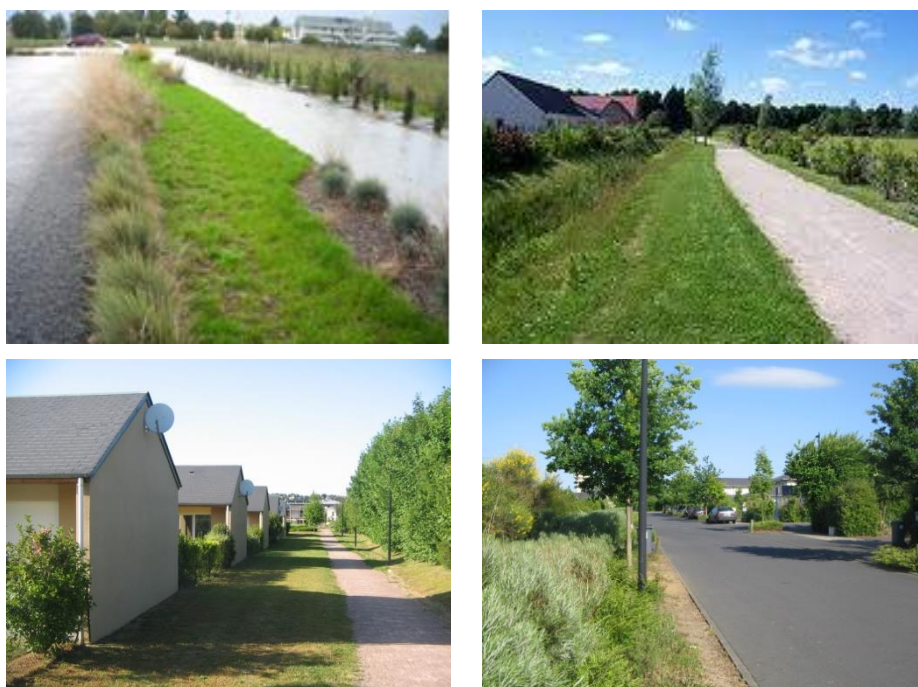
Exemples de noues paysagères et cheminements piétonniers
